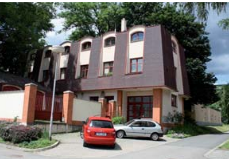
Budova izolačních stájí
